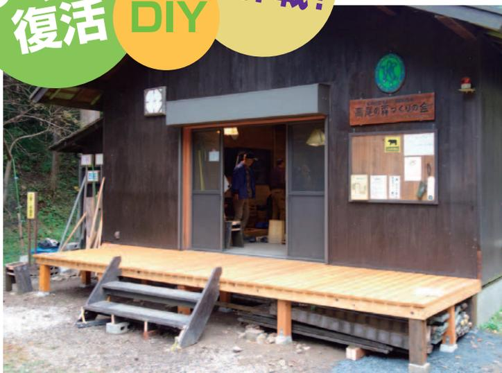
既存のウッドデッキは、ベース小屋建設に伴い当会員の手で2006年4月に造られた。その後数年前デッキの独立柱、床板を支える大引きおよび床板の補修工事がなされたが、昨年9月に有志数名で既存デッキの床板を剥ぎ取り、床板、大引き、独立柱等の劣化調査を行ったところ、大引きの腐朽が激しくデッキとして危険な状態であることが判明した。その結果、デッキの一部を補修ではなく全面改築することとなった。
