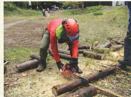
旧丸太橋解体
