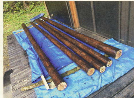
防虫防腐剤塗布
