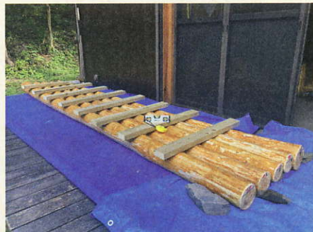
組立確認、強度確認
