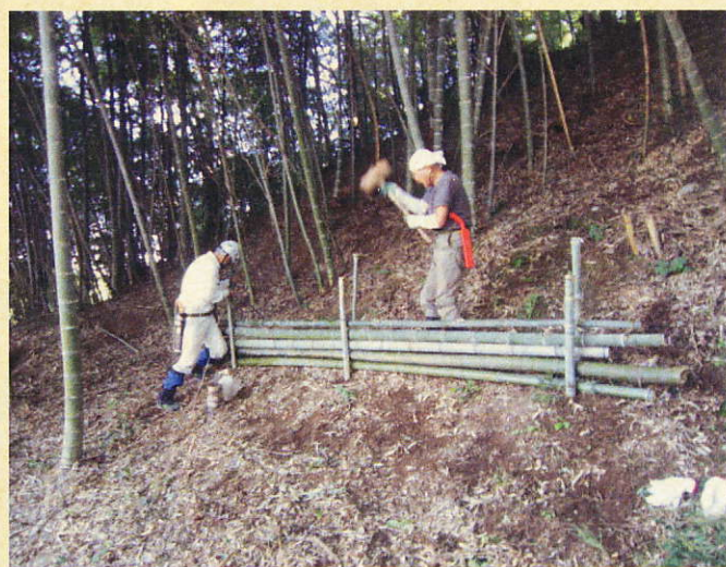
上柚木公園土留づくり
