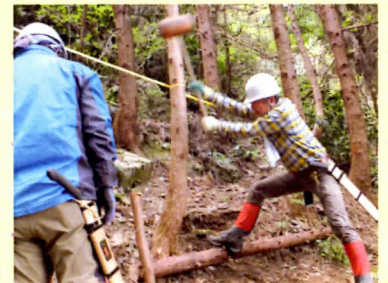
板当作業道も順調に進んでいます
