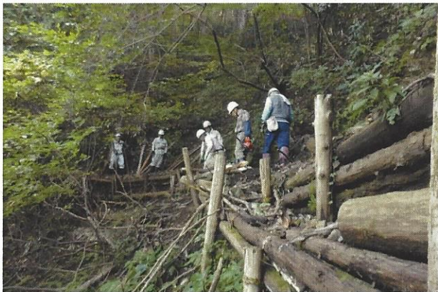
道の補修現場に杭材など終結
