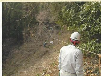
架線を使って客土の運搬(D班)
