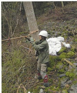
架線による客土の運搬
